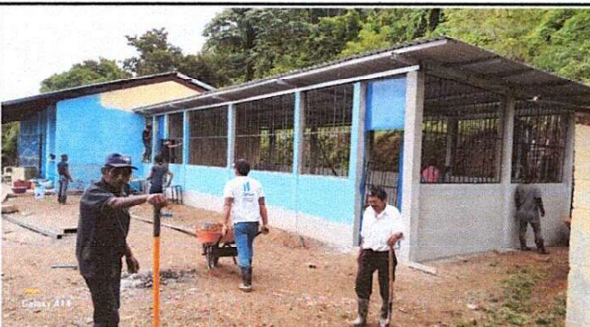
Foto 3: remodelacion de pintura lado exterior de aulas
