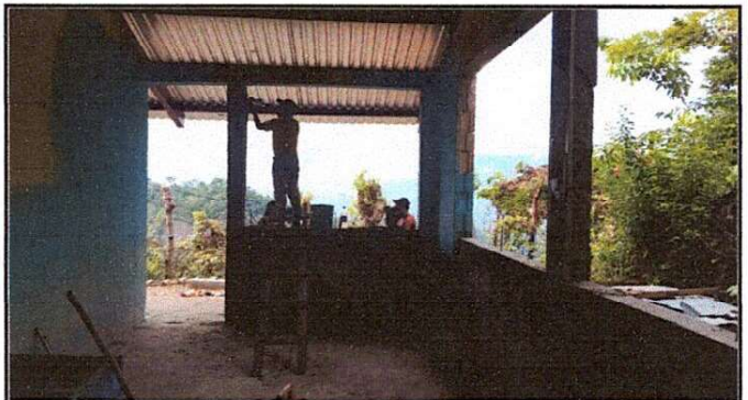
Foto 4: medicion donde se ubicarán puerta y balcones
