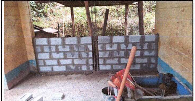
Foto 2: mantenimiento lado trasero de cocina
