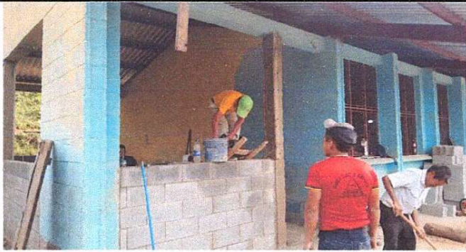
Foto 1: Mantenimiento lado frontal de cocina
